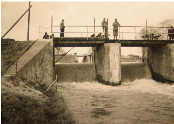
Bruisende sluisen van 't Werk aan 't Spoel in Culemborg in het voorjaar van 1940. Het water dat langs fort Pannerden is gestroomd, wordt hier naar de inundatievelden van de Diefdijklinie geleid. (Foto: G. Jansen, voormalig fortcommandant).
