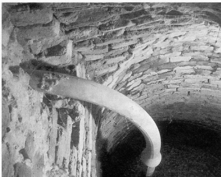
Foto 16: Waterput met loden waterleiding naar pomp
