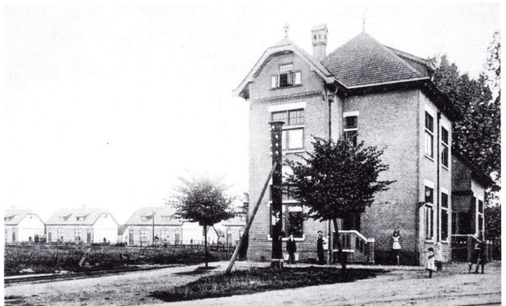
Administratie Gebouw B. S. M. - Bemmeler
