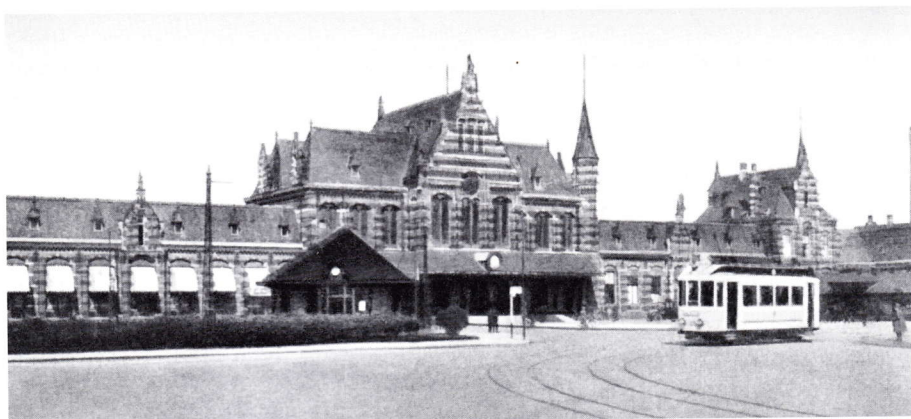
Afb. 18. Het vooroorlogse station van Nijmegen. Na de ingebruikneming van de Waalbrug in 1936 was dit station rechtstreeks vanuit de Betuwe met de bus te bereiken.
