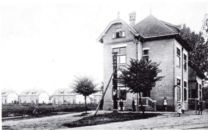
Administratie Gebouw B. S. M. - Bemmeler
