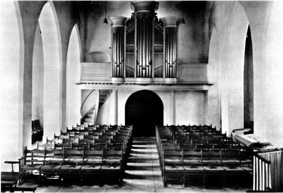
Het schip van de kerk na de restauratie, met zicht op het vernieuwde orgel.
