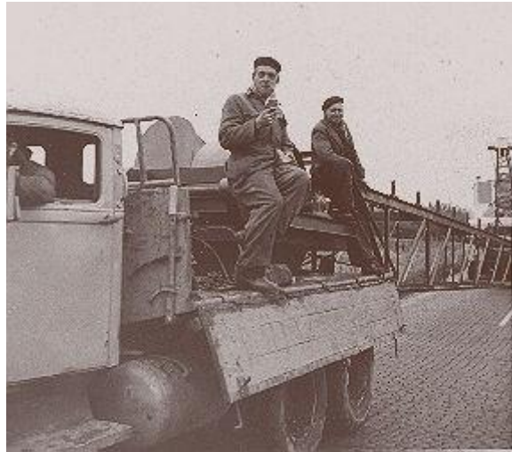
Cor Grob (r) en Henk Scholten van steenfabriek 'De Zandberg' Op de vrachtauto een transportrol voor een excavateur
