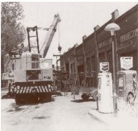
WIDO hijst een zware machine op een oplegger van Derks
